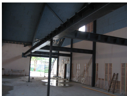
Stålkonstruktionen, der skal bære den kommende balkonetape
