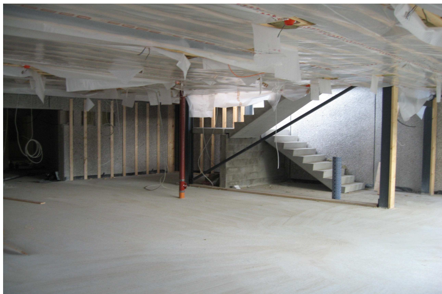
Den nye trappe, som leder fra foyeren til den nye restaurant.
